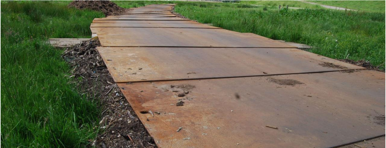
Het gebruik van rijplaten is effectief in het verminderen van ondergrondverdichting © van Schie
