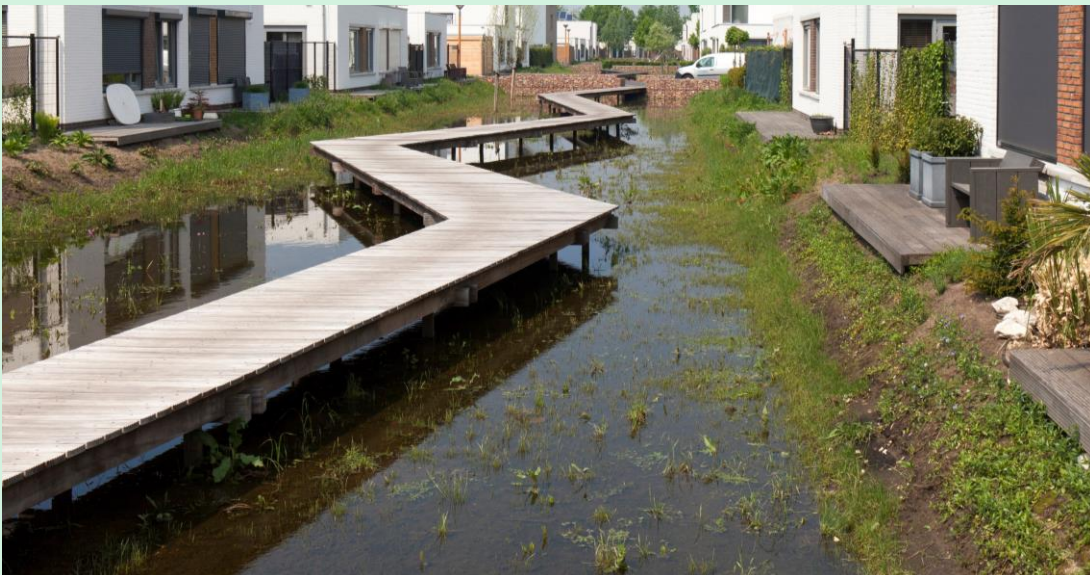
Aanleg van een wadi is een voorbeeld waarin klimaatadaptatie en natuurinclusief bouwen samenkomen en waarbij ook de bodem gebaat is. © Stichting Steenbreek | Sjon Fotografie
