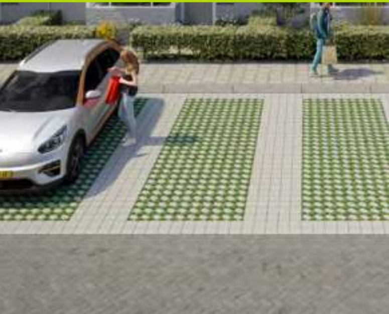
Toepassingen met verschillende Gradiënt-tegels: links de ovale (65% groen) met loopgedeelte van gesloten tegels (5% open voor infiltratie); rechts de ovale, vierkante (33% groen) en gesloten tegels. Beeld: Studio Buil
