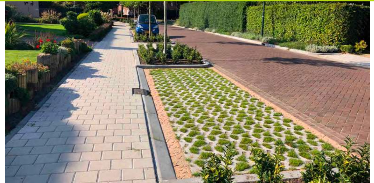
Groene parkeerplaatsen zorgen met name in vaak versteende woonstraten dat het regenwater weer de bodem in kan. Beeld: Rain(a)Way
